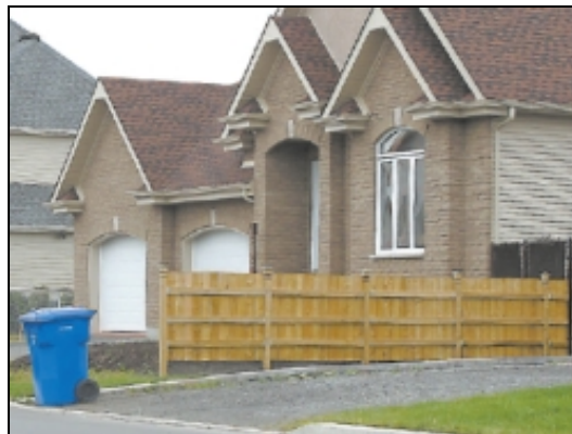
Cette clôture de bois, érigée sur un terrain de Blainville, est trop haute de 10 pouces et obstrue la vue des voisins. © Marc Pigeon
